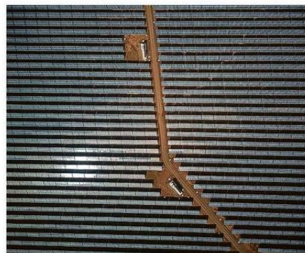
SOLO EN 2022 SE INSTALARON EN LA REGIÓN 79 PARQUES FOTOVOLTAICOS.
