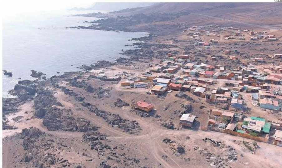
PESE A QUE EN NOVIEMBRE DE 2022, LA GOBERNACIÓN PROVINCIAL NOTIFICÓ EL DESALOJO DE ESTOS ESPACIOS, LAS TOMAS CONTINÚAN CRECIENDO.
