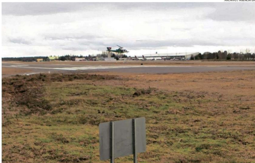
LA DIRECCIÓN NACIONAL DE AEROPUERTOS INFORMÓ QUE LAS OBRAS DE LA NUEVA PISTA DE EL TEPUAL, COMENZARÍAN EN EL AÑO 2027.
