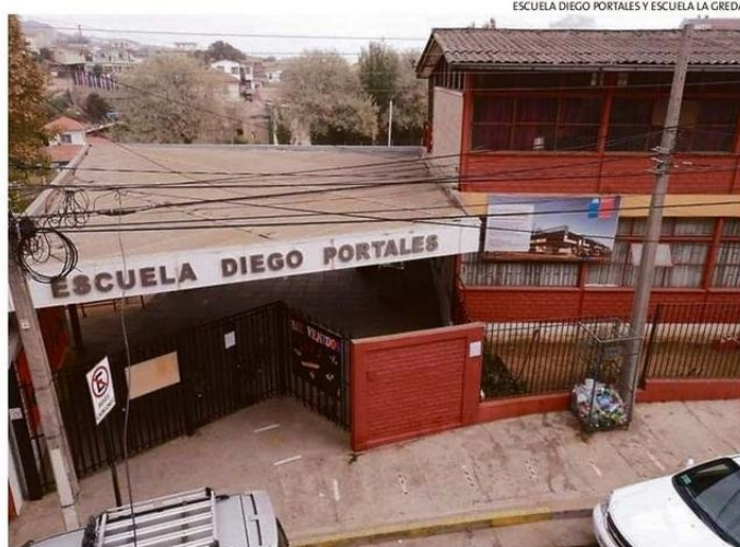
TRABAJOS EN ESCUELA DIEGO PORTALES DE PLAYA ANCHA, VALPARAÍSO, SERÁN POR $336 MILLONES.
