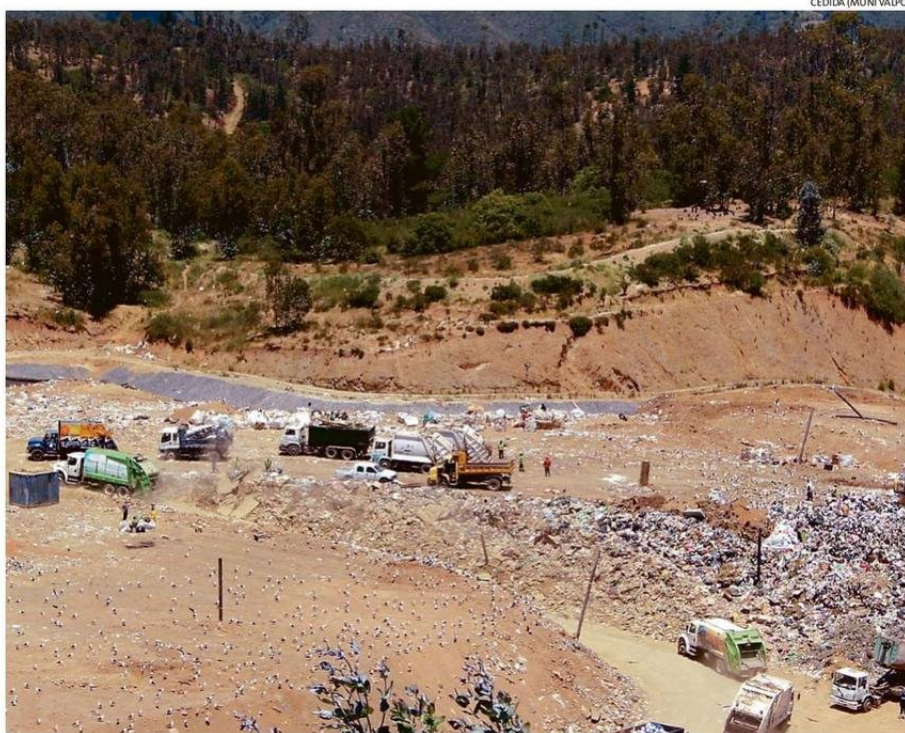
SEGÚN EXPERTO, RELLENO SANITARIO EMPLAZADO EN VALPARAÍSO ES COMPLEJO EN TÉRMINOS TOPOGRÁFICOS.
