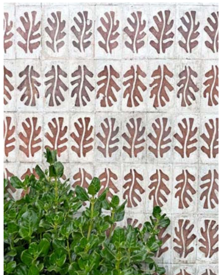
Muros de la Remodelación Paicaví (Grupo TAU, 1966), acá usaron un formato rectangular con motivos orgánicos.
