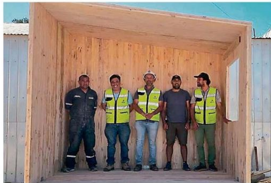
El proyecto "Panel CLT-R" desarrolla viviendas industrializadas con paneles de madera contra laminada reforzada.
