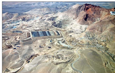
El contrato entre Codelco y CBM era para desarrollar obras en la división Salvador, en el proyecto estructural, Rajo Inca.
