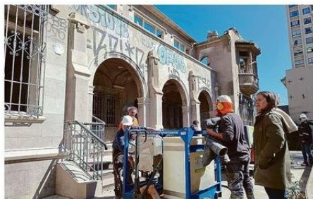
LA LABOR SE HACE CON VIDRIO MOLIDO PRESURIZADO CON AGUA.
