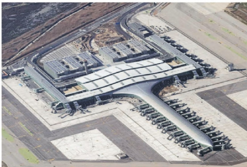
En la ampliación del Aeropuerto de Palma de Mallorca, ACCIONA utilizó un tipo de acero compuesto en un 93% de materiales reciclados, lo que evitó la generación de 1.900 tons. de emisiones de CO 2 . Foto: ACCIONA.
