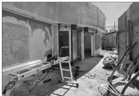
Ya se está trabajando en la construcción de la nueva Farmacia Comunal de Quillota.
