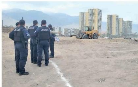
DURANTE ESTOS DÍAS SE TRABAJA EN INSTALAR PRETILES.
