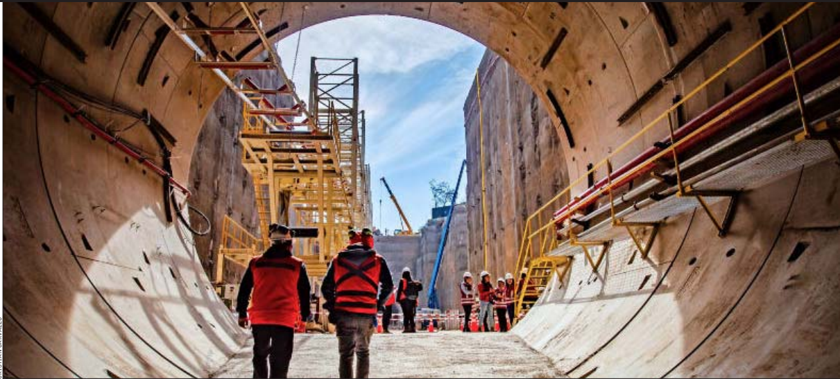
El túnel de la Línea 7 se está construyendo a medida que la tuneladora va excavando el terreno: mientras avanza, se van instalando las piezas de hormigón.
