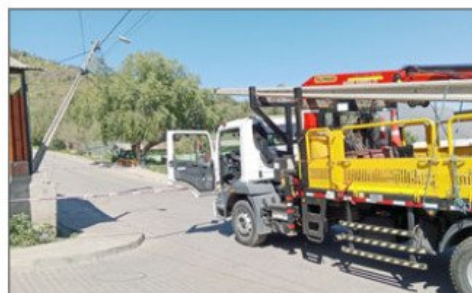
Personal de Chilquinta llegó hasta Algarrobal a reparar los postes.
