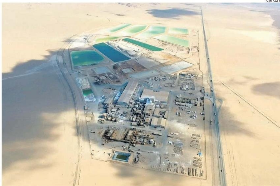
EL PROYECTO CONSISTE EN UNA AMPLIACIÓN PARA AUMENTAR SU CAPACIDAD DE PRODUCCIÓN EN LA YA EXISTENTE PLANTA DE CARBONATO DE LITIO.
