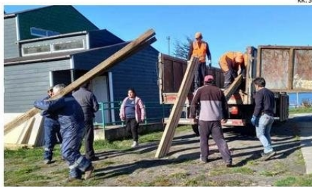
ARRIBO DE MATERIALES PARA CONSTRUCCIÓN DE CAMARINES.
