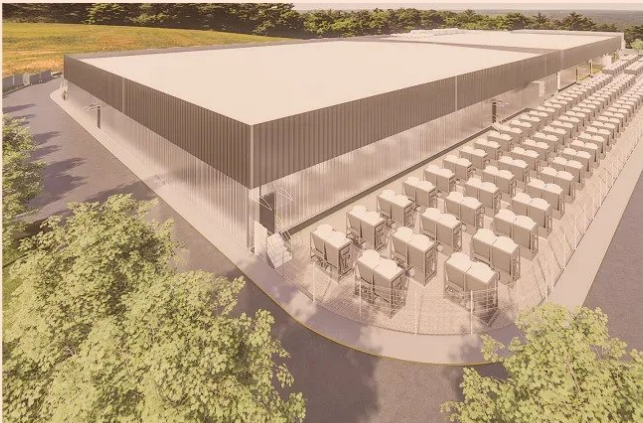
Los centros de datos de Cirion tienen calidad certificada con normas internacionales y nivel Tier III. Además, son carrier neutral (+95 carriers conectados) y cuentan con múltiples acuerdos de Peering.
