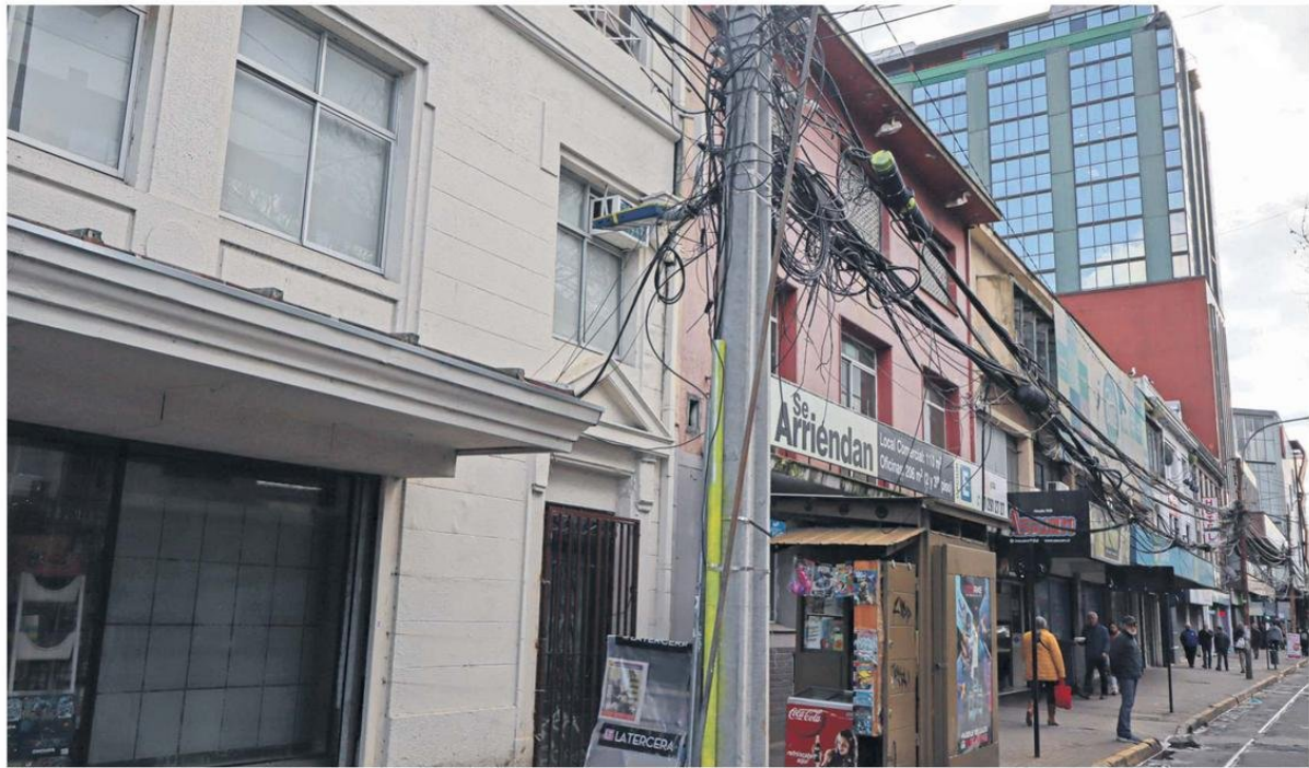
La cantidad de cables en los postes es evidente y plantea un riesgo para los transeúntes y vehículos cuando, además, quedan colgando sin uso.
