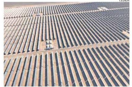
LAS OBRAS COMENZARÁN EL PRIMER SEMESTRE DEL PRÓXIMO AÑO.
