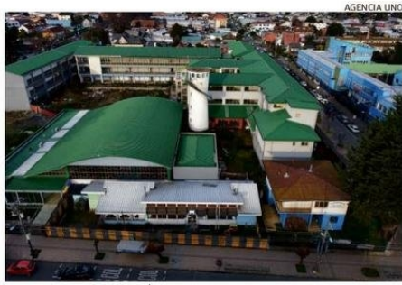
LAS OBRAS DEL LICEO ESTÁN PARALIZADAS DESDE MAYO DEL 2022.
