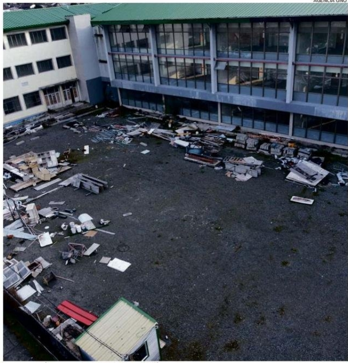
A LA LICITACIÓN PARA ESTAS LABORES SE POSTULÓ SOLO UNA EMPRESA PARA TERMINAR EL 35% PENDIENTE.
