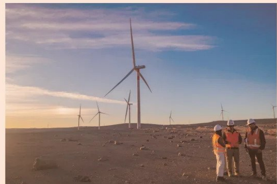
Parque Eólico Horizonte, Colbún S.A.
