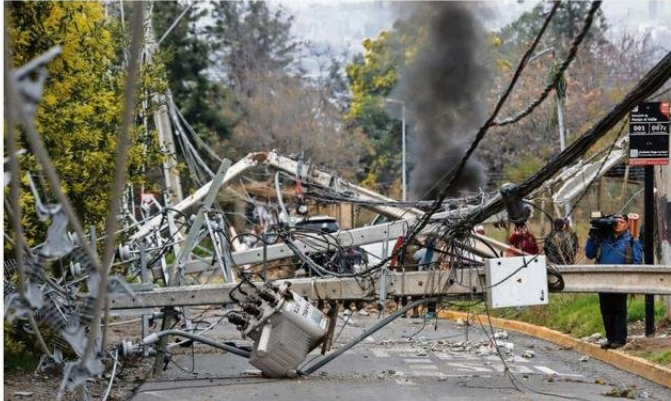
INFRAESTRUCTURA ELÉCTRICA FUE DAÑADA POR VIENTOS DE MÁS DE 120 KM/H EN LA CAPITAL, A INICIOS DE MES.
