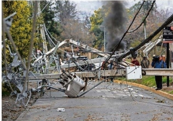
INFRAESTRUCTURA ELÉCTRICA FUE DAÑADA POR VIENTOS DE MÁS DE 120 KM/H EN LA CAPITAL, A INICIOS DE MES.
