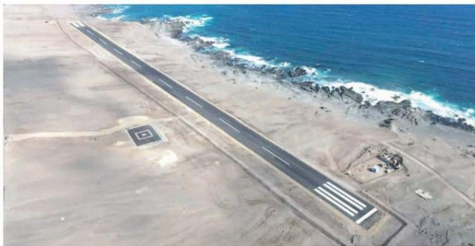
LA PISTA TIENE 600 METROS DE LONGITUD Y ADEMÁS HAY UN PUNTO DE POSADA PARA HELICÓPTEROS.
