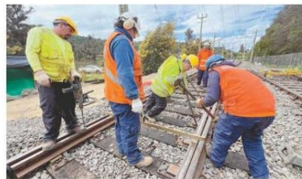
EMPRESA REALIZÓ TRABAJOS EN LA VÍA DURANTE ESTA SEMANA.
