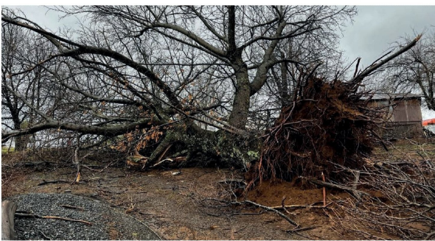
EN LA PROVINCIA DE BIOBÍO hubo sectores rurales con más de 15 días sin suministro eléctrico.
