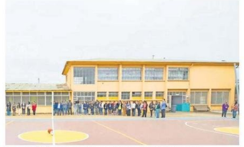
La escuela tiene recurrentes cortes de electricidad y agua.
