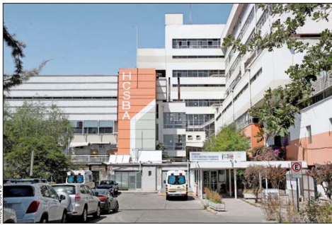
IMPLEMENTACIÓN .—A raíz del incendio de 2021 en el Hospital San Borja Arriarán, en Santiago, se instalaron módulos de atención.
