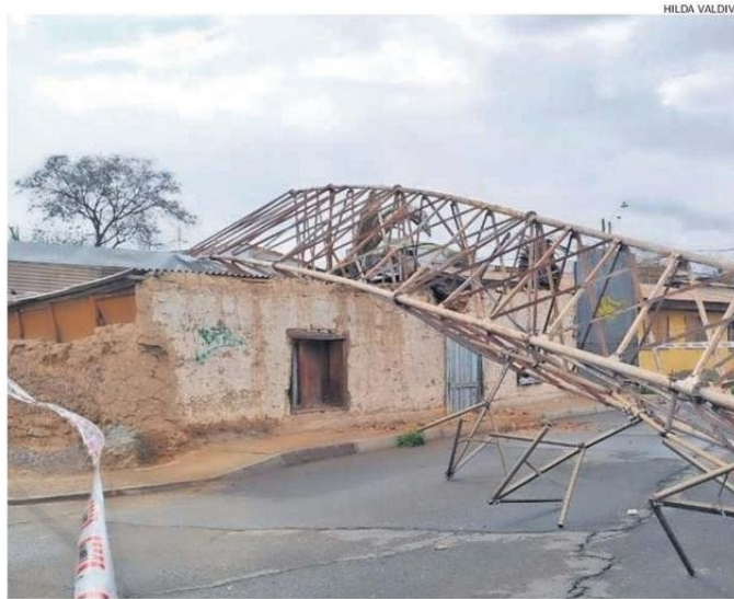
LA CASA DONDE CAYÓ LA ESTRUCTURA.
