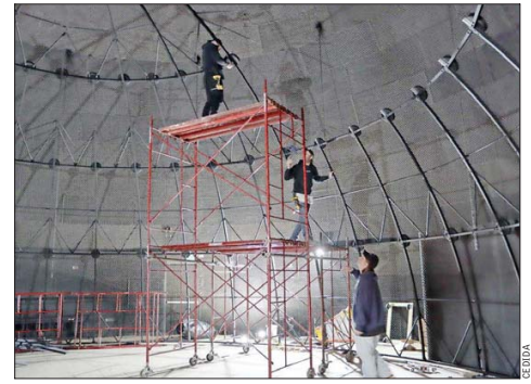
Actualmente, se trabaja en el armado de la estructura que soportará la pantalla de aluminio microperforado, que será la encargada de generar imágenes más realistas y nítidas.
