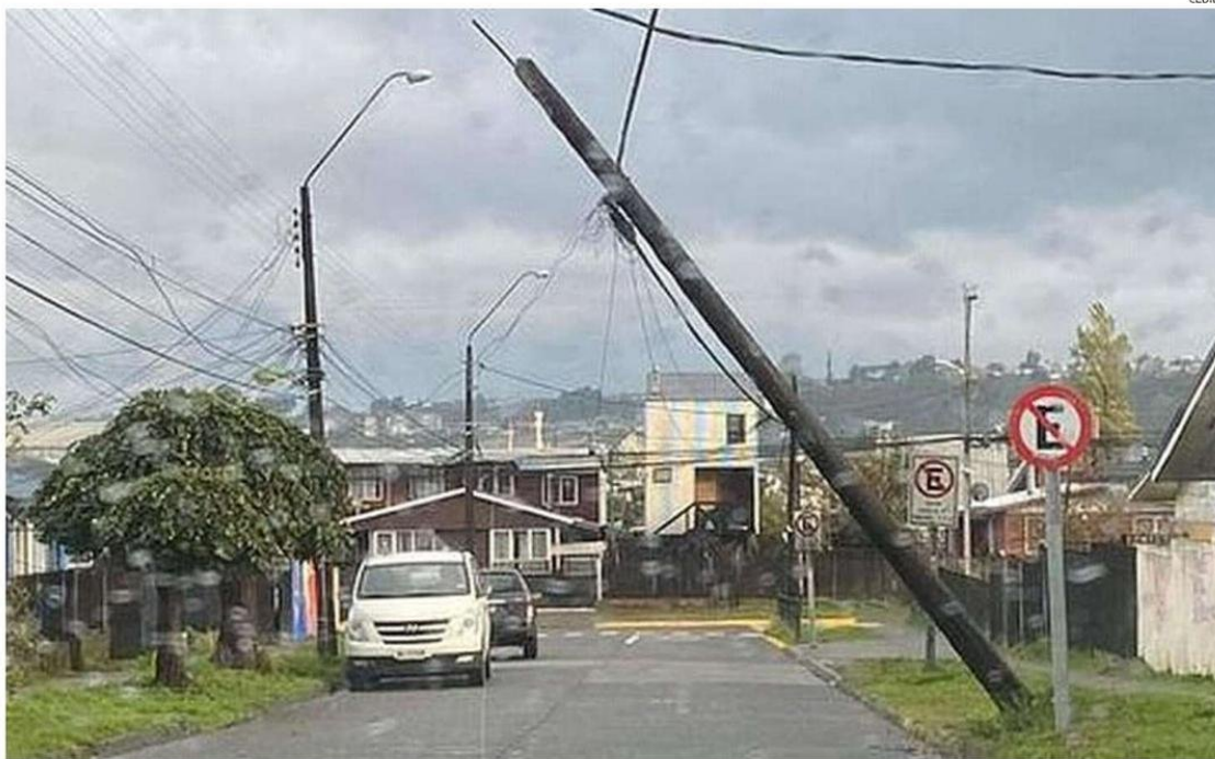
EL VIENTO PROVOCÓ VARIOS CORTES EN EL SUMINISTRO DE ENERGÍA ELÉCTRICA.
